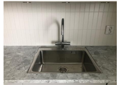
Höganäs Evolution white matt 50x200x9,3 mm stående korsförband, ljusgrå fog.
